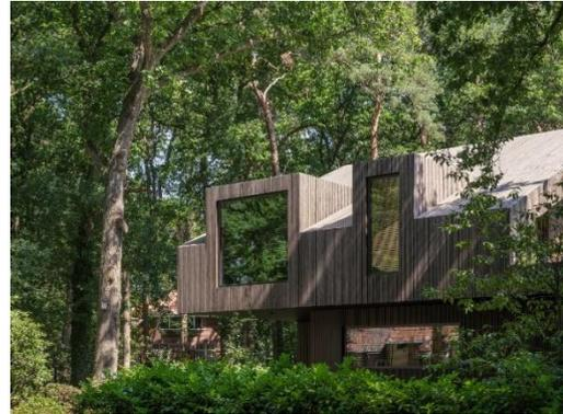
*Tanto la fachada del SPEEHUIS como el tejado inclinado está acabado con listones MOSO® Bamboo X-treme®, instalados sobre el sistema Grad que hace que la instalación quede oculta y sea desmontable. "El bambú de alta densidad de MOSO® es, en mi opinión, uno de los productos de base biológica más sostenibles que existen en la actualidad. Debido a sus propiedades únicas, también sigue siendo bello a largo plazo, siempre que se le den los detalles adecuados", dice Bart Spee, de Spee Architects.*
