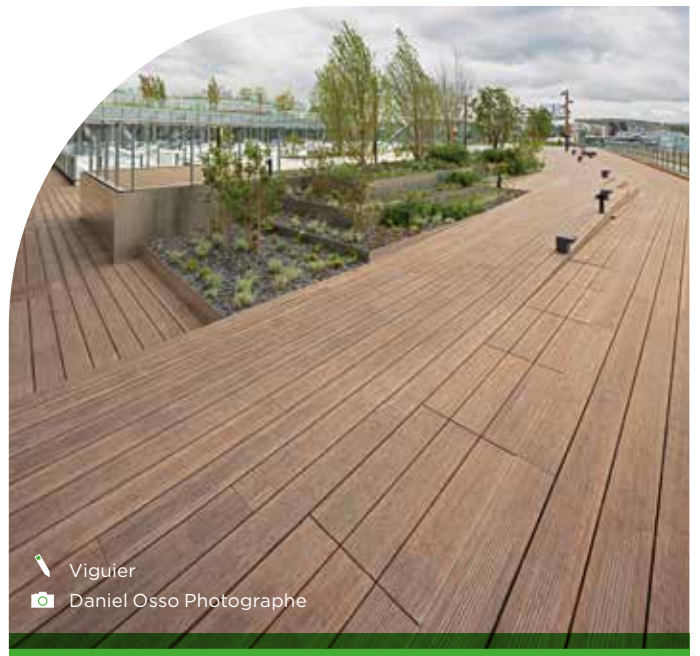
Bridge Pont d'Issy Siège Social Orange (1200 m 2 ) Issy-les-Moulineaux, France
