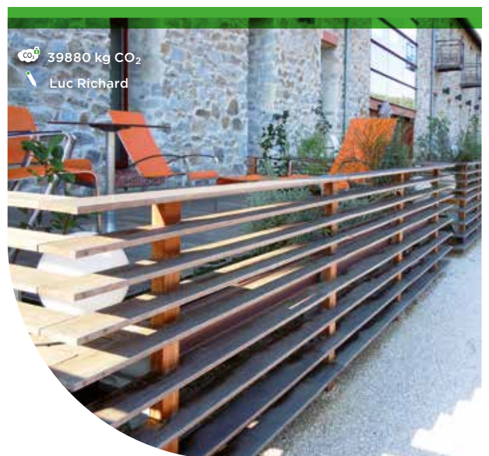
Hotel Riberach foto tomada 8 años después de la instalación - (1.200 m 2 ) Bélesta, Francia
